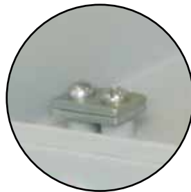
Надежное крепление силового элемента кабеля
