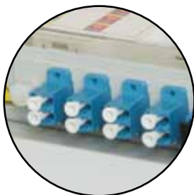
Сменные пластины с оптическими адаптерами
